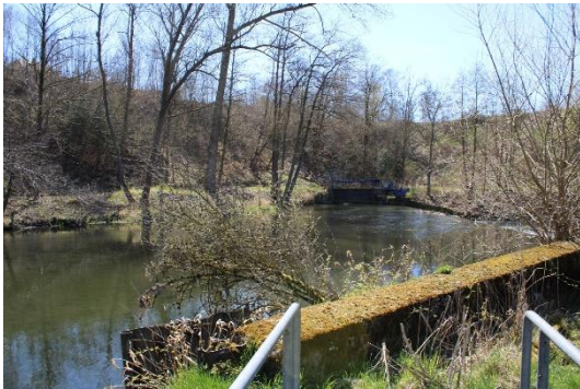
Abb. 5 Stauwehr der Ruhr im südwestlichen Bereich des Plangebiets.
