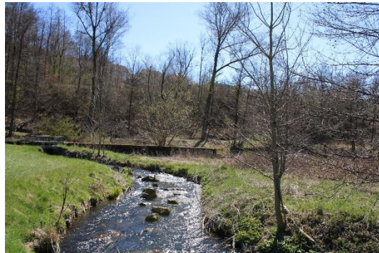
Abb. 6 Blick über den Fischpass auf das Stauwehr.
