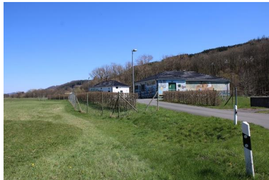
Abb. 8 Gebäude des Wasserwerks Mengesohl mit Eingrünung (Hainbuche) und asphaltierter Zufahrt.
